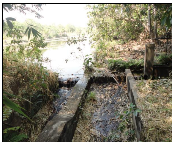
Extensão do extravasor
