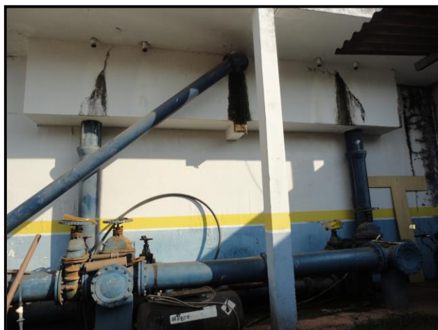
Tubulações de chegada de água bruta
