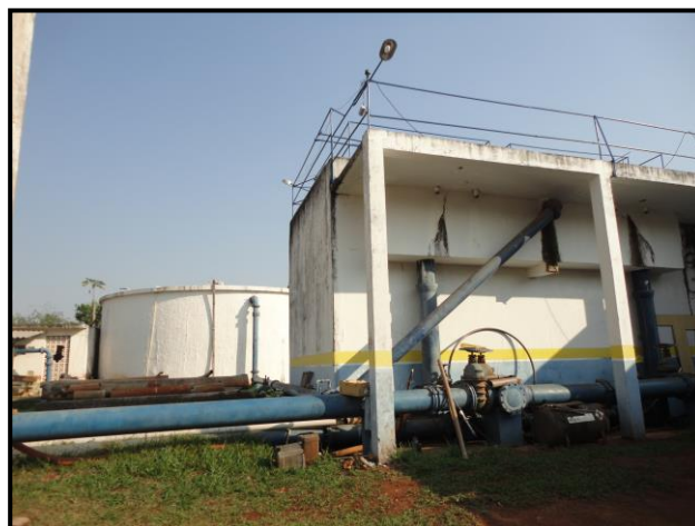
Tubulações de chegada de água bruta
